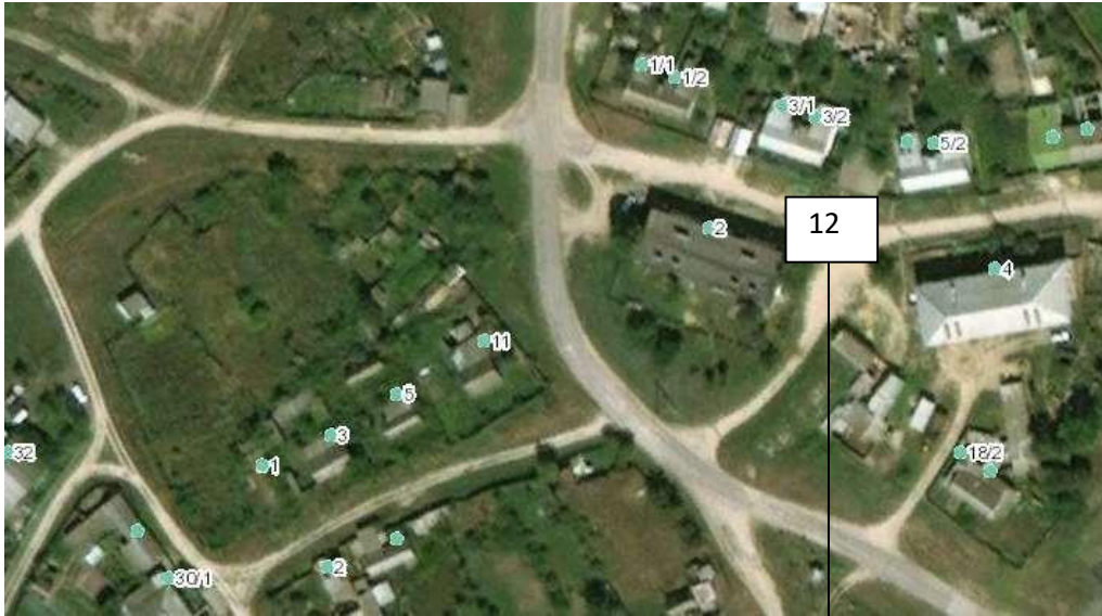
Место накопления (площадка) ТКО
